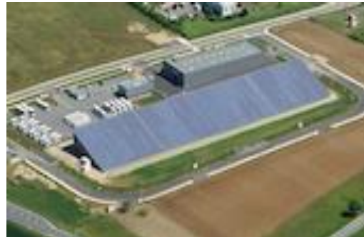
Cubierta Integrada Potencia Total: 1.000 kWp.
